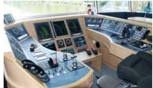
Der moderne Einmannfahrstand im Wessels-Steuerhaus, technisch innovativ ausgestattet von Naval Marine in Duisburg/ Ludwigshafen, lässt keine Wünsche offen
