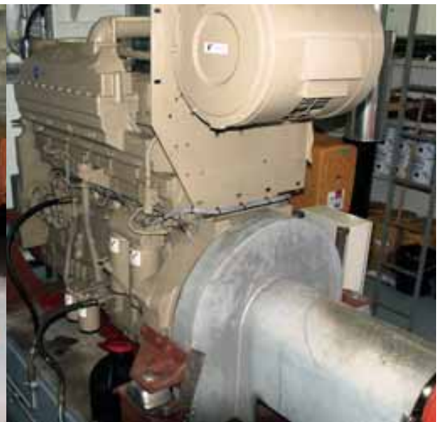
... die von 630 PS leistenden Cummins KTA 19G3 Dieselmotoren angetrieben werden
